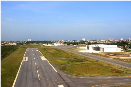
Vista aérea da cabeceira da pista do Aeroporto
