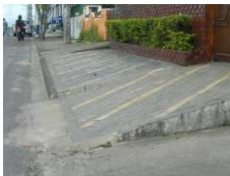
Foto 33 - Calçada com rampa e descontinuidade
