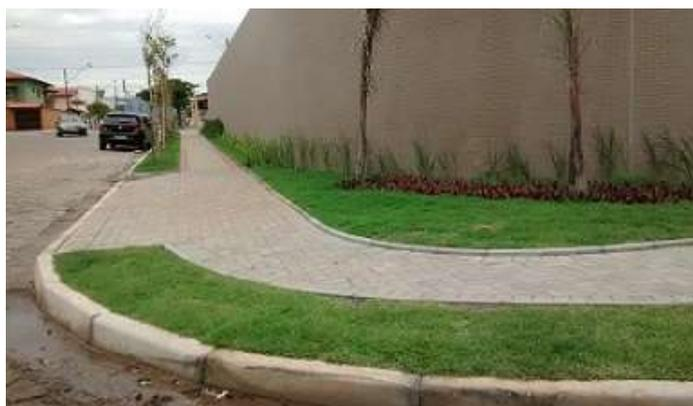
Foto 66 - Calçada do empreendimento Resort Itanhaém, construída com o conceito das 3 faixas
