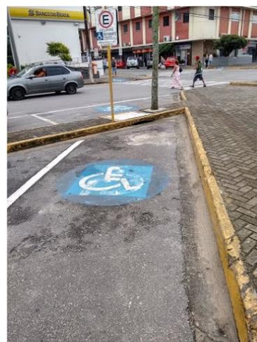
Foto 60 - Vagas de estacionamento de deficientes fora do padrão e sem rampas de acesso
