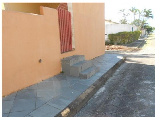
Foto 29 - Calçada estreita, pavimento não indicado para ambientes externos e escada de acesso ao imóvel no passeio - grande obstáculo
