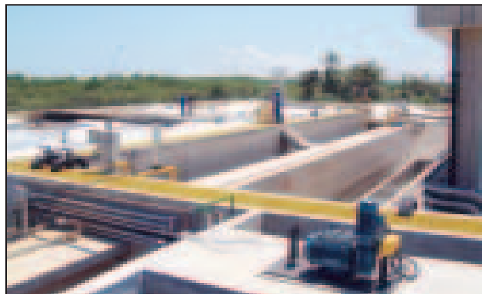
SANEAMENTO BÁSICO • Investimentos de R$ 8 milhões na construção do Sistema de Tratamento de Esgoto no Anchieta
