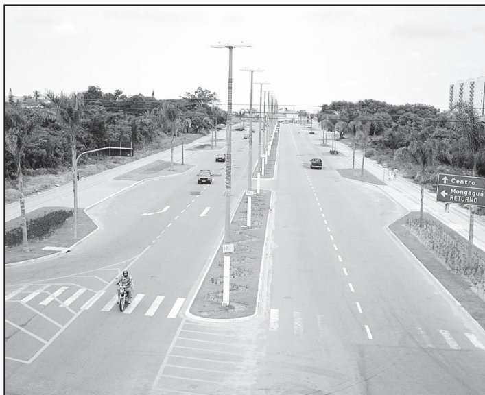
Urbanização da nova entrada da cidade, Avenida Jaime de Castro
