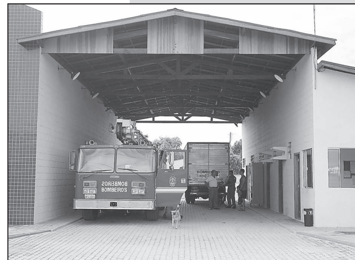
Instalação da Unidade do Corpo de Bombeiros em parceria com o Fundo Metropolitano
