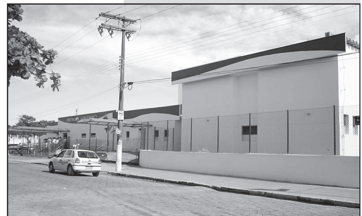
HOSPITAL MUNICIPAL • Obras de reforma e ampliação entregues no dia 22 de abril
