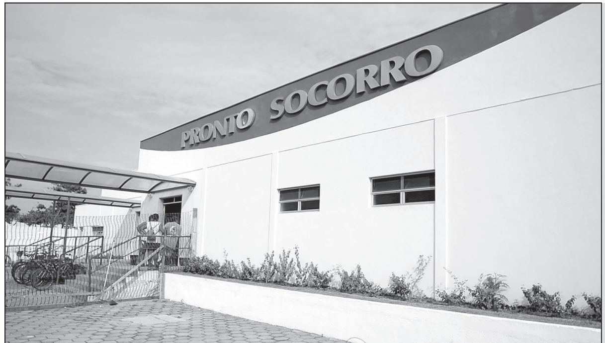
O Pronto Socorro do Centro foi totalmente reformado e ampliado: atendimento com dignidade
