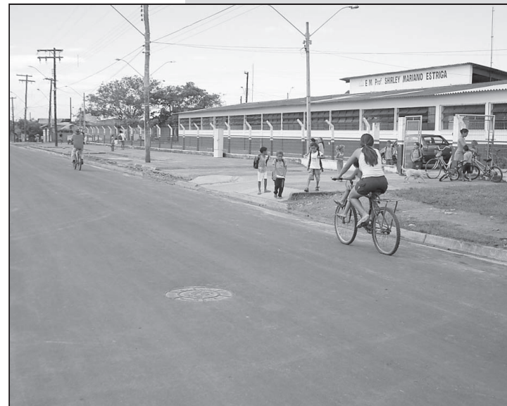
Urbanização e pavimentação asfáltica da Avenida Emídio de Souza no Jardim Oásis
