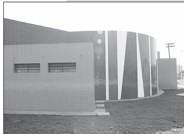
Construção do anfiteatro na Escola Municipal Noêmia Salles Padovan (Guapiranga II)
