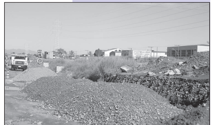
VIADUTO • A construção do viaduto no trevo da rua João Mariano Ferreira já foi iniciado
