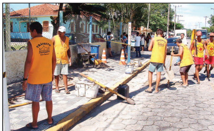
MANUTENÇÃO • A equipe do departamento realiza constante manutenção da pintura de solo
