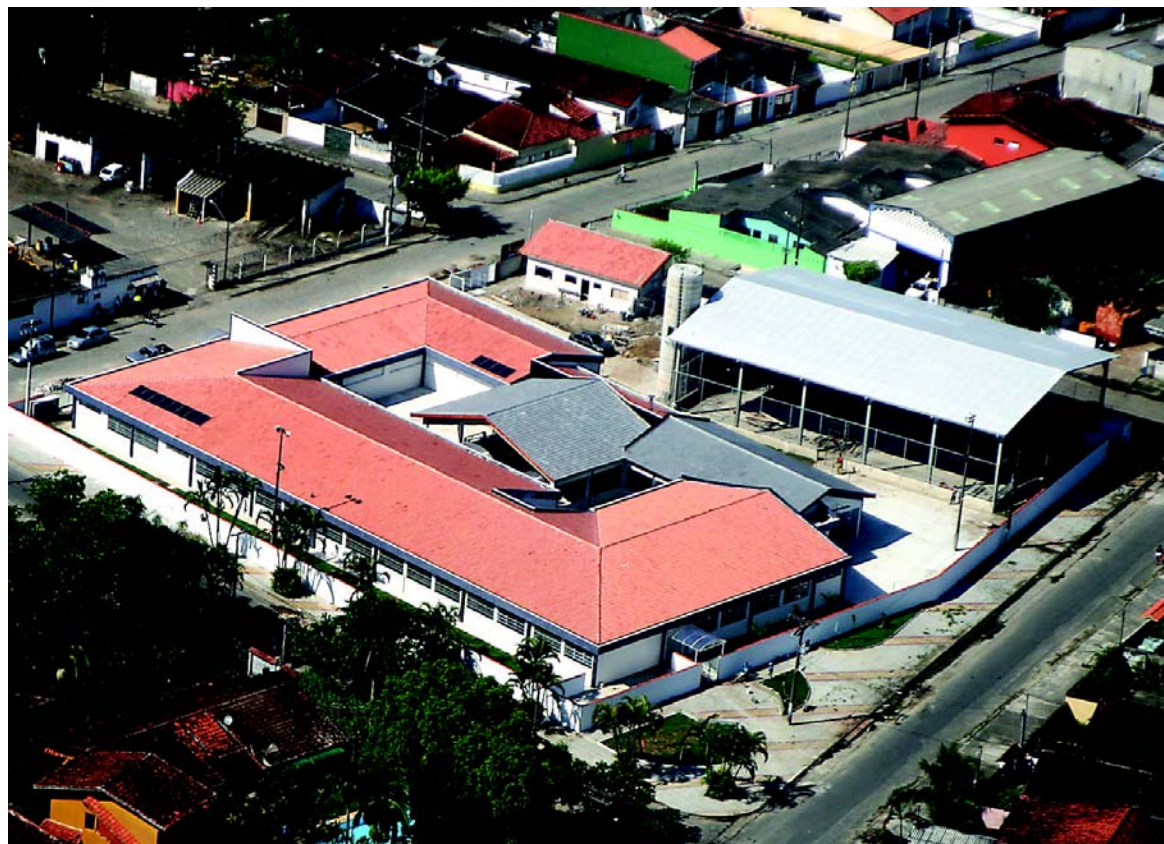
Com o investimento de mais de R$ 2 milhões, a nova escola contará com aproximadamente 2.500m 2 de área construída e beneficiará cerca de 400 alunos com ensino integrado de 4 meses até 10 anos
