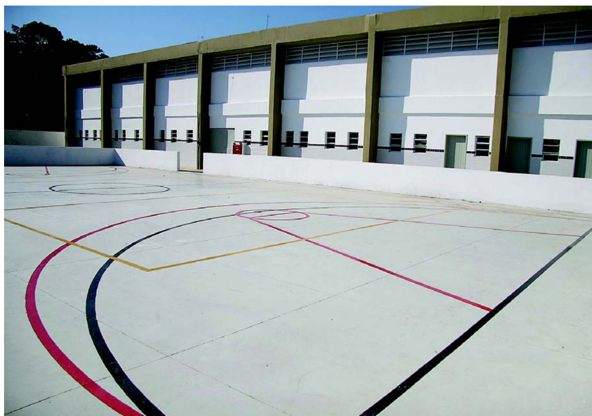
O novo ginásio poliesportivo da E.M. Maria Soares Amêndola possui duas quadras, sendo uma coberta, vestiários e arquibancada para 700 pessoas
