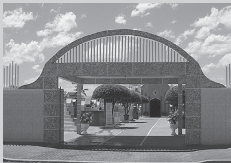
Cemitério no Centro recebeu serviços de manutenção e limpeza
