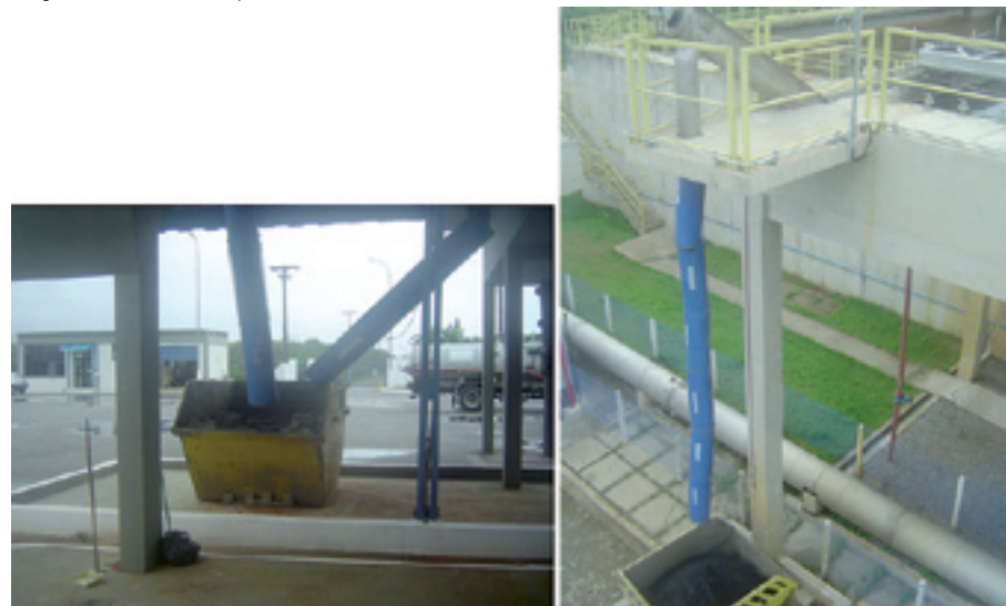
Foto 22- Detalhe da retirada de areia da ETE – Fonte: Prefeitura
