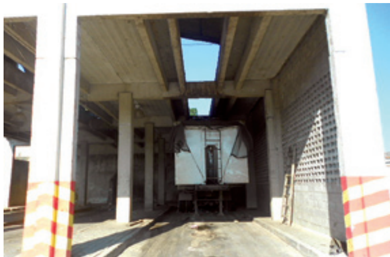
Foto 2- Estação de transbordo - vista do poço com carreta Fonte: Prefeitura, 2014
