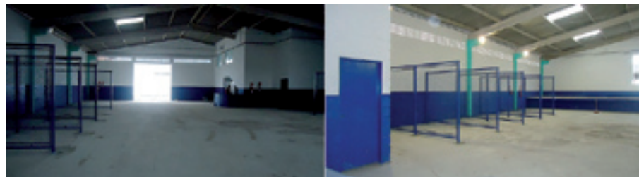
Foto 10 - Vista interna do Galpão - Foto de 2012 Fonte: Prefeitura de Itanhaém
