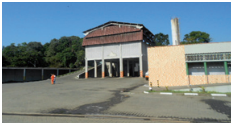
Foto 1- Estação de transbordo, vista geral Fonte: Prefeitura, 2014
