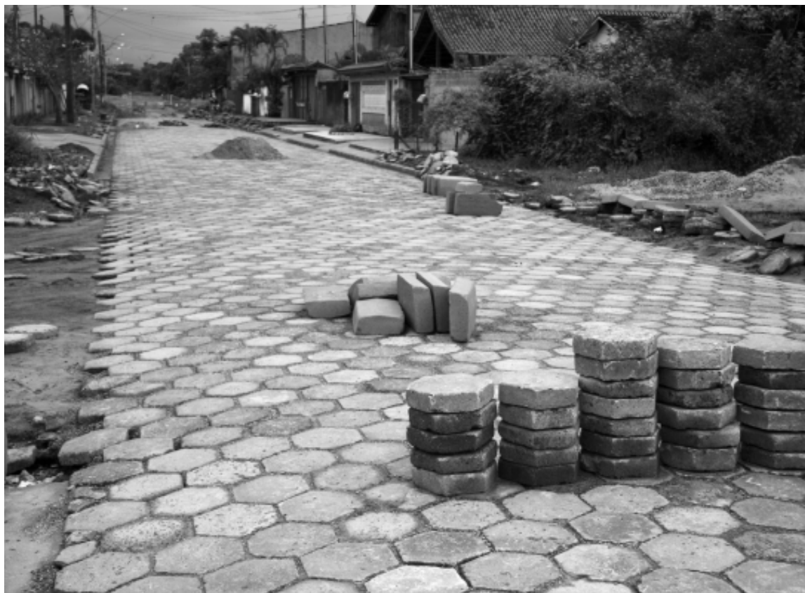
O serviço, iniciado no mês de agosto, está sendo realizado com lajotas que foram retiradas de vias do Centro, contempladas com reurbanização, como a avenida Rui Barbosa e rua Cunha Moreira
