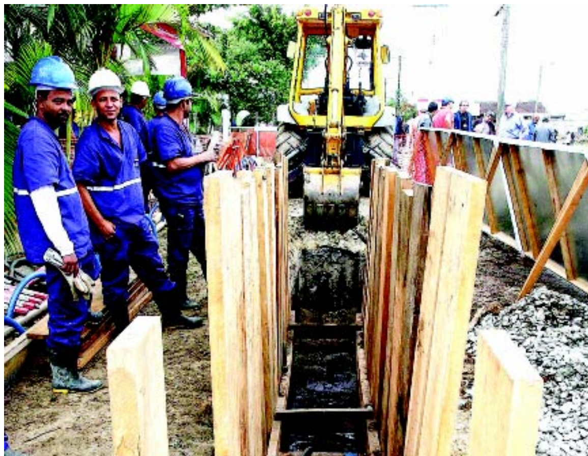
Mensalmente são feitas entre 8 e 10 km de redes coletoras e já no mês de junho serão inauguradas três Estações Elevatórias de Esgoto (EEE) e 1.500 pontos de ligações domiciliares
