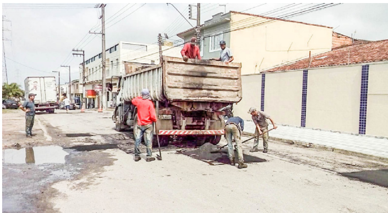
A Administração utilizará cerca de 180 toneladas de massa asfáltica em todas as obras
