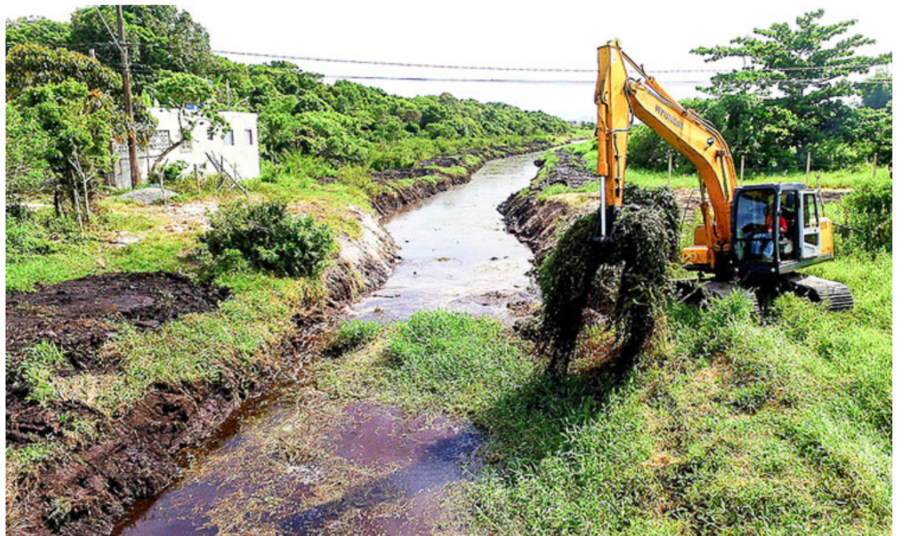
Atualmente está em andamento a limpeza do Braço do Rio do Poço, em frente ao Rio Cavuçu
