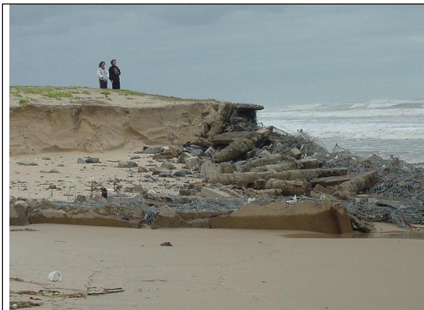
Foto de 2002, com caiu um muro que protegia uma antiga estação de teste de materiais da CESP
