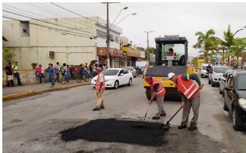
Os serviços de tapa-buracos trazem mais segurança e melhoram a mobilidade urbana. As ações foram executadas em diversos pontos da Cidade
