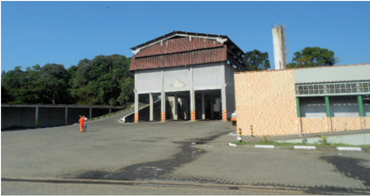
Foto 1- Estação de transbordo, vista geral Fonte: Prefeitura, 2014
