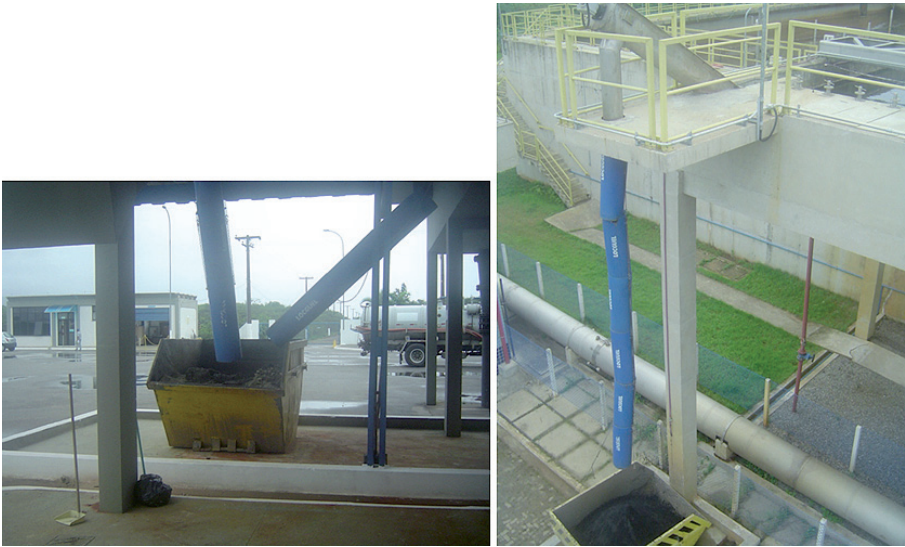
Foto 22- Detalhe da retirada de areia da ETE – Fonte: Prefeitura Foto 23 - Detalhe da retirada de areia da ETE– Fonte: Prefeitura
