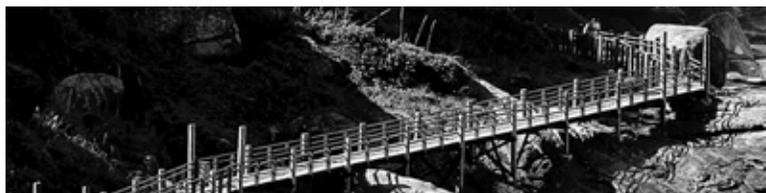
■ A Passarela de Anchieta é uma ponte de 220 metros de comprimento por 1,60 de largura, construída com ipê e materiais derivados do eucalipto ecológico sobre a formação rochosa entre a Praia do Sonho e o mar. A obra foi concretizada graças à parceria entre o Executivo de Itanhaém e o Governo das Ilhas Canárias, em La Laguna.
