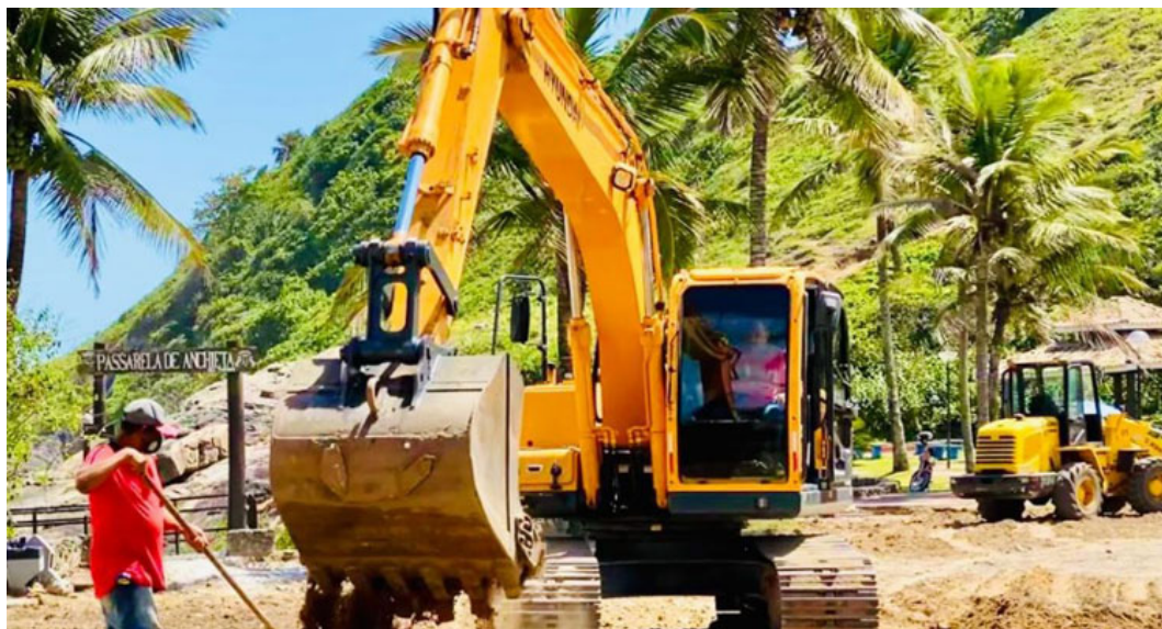
As intervenções incluem a instalação de bancos, postes ornamentais, calçadas em intertravado vermelho, estacionamento em lajota sextavada de concreto e tubulação de drenagem
